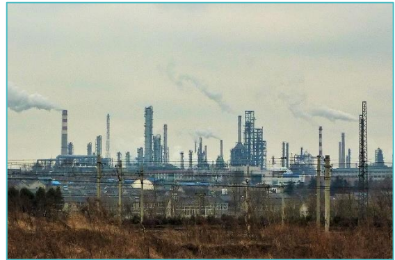
الشكل 14: مصفاة جينلينغ للنفط ، تشيشيا ، نانجينغ. بواسطة المستخدم: Vmenkov - عمل خاص ، CC BY-SA 3.0.
